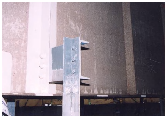
ボルト部補修
