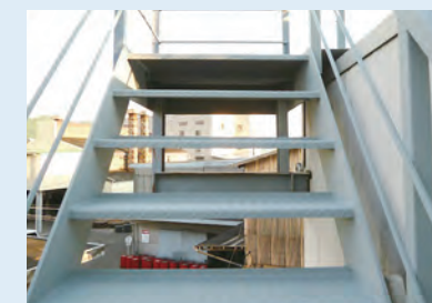
外部鉄骨階段
