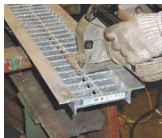
グレーチングをカット
