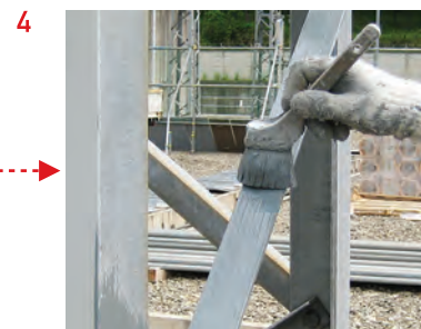
ローバル塗装 一般塗料のように塗り延ばさずに たっぷりと塗る
