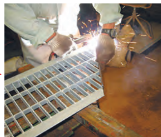
黒皮を除去したフラットバーを切断面に溶接
