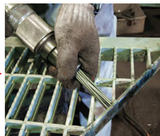
ジェットタガネでノロ、スパッターを除去
