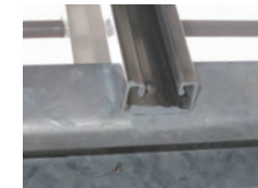
ZAM鋼板の端面補修
