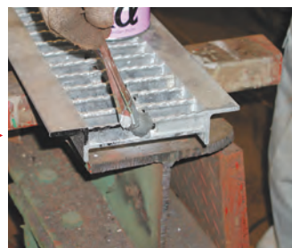
切断面にローバルアルファを塗装 (2回塗りしてください)
