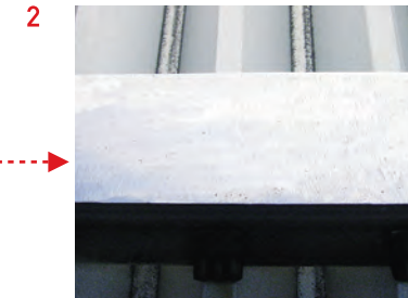
清浄な鉄面を露出させる
