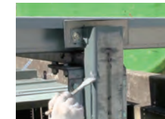
亜鉛めっき面に直接塗れる
