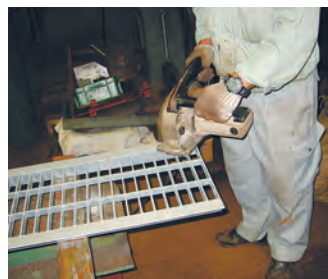
グレーチングを斜めにカット
