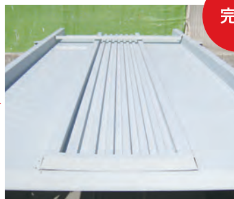
塗装完了 24時間完全乾燥後、入庫可能
