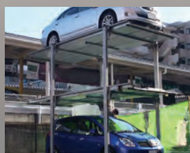
機械式立体駐車設備
