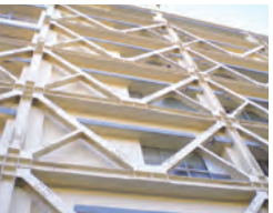
施工例(耐震補強工事)
