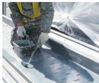
ローバル塗装 鉄・亜鉛めっき面に直接塗装する
