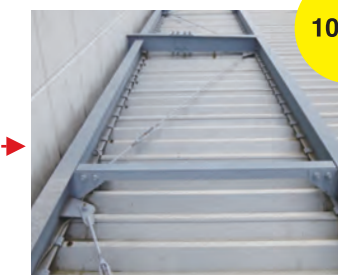
施工から10年後の様子
