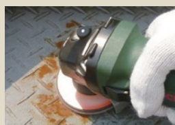
赤さび部に、電動工具を用いて完全に除去。
