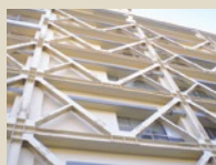
施工例(耐震補強工事)
