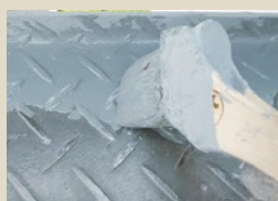
すみやかに補修箇所をローバルで塗装。
