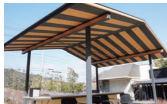
屋根の梁・柱
