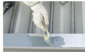
ハケ、ローラーを使用し一度に厚塗りをせず、われ防止のため2回に分けて塗ります。\* (ドライ40μmが目安) さび止め能力は膜厚に比例します。
