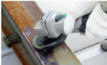
ブラストまたは動力工具を使用して、水分・油分・黒皮・さび・旧塗膜を除去し、清浄な金属面を露出させます。
