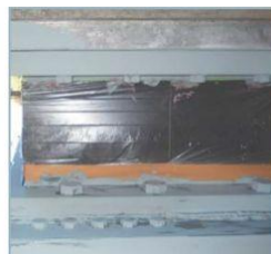
高架橋支承部
