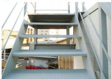
外部鉄骨階段
