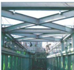
駅ビル渡り廊下
